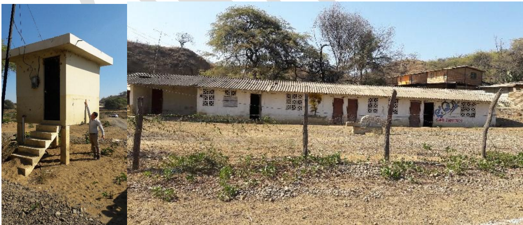
Fotos 13 y 14. Pozo de bombeo en el barrio Miraflores y casa comunal del barrio Lalamor
