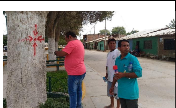
Foto 12. Marcación de puntos de instalación de señalética en Querecotillo
