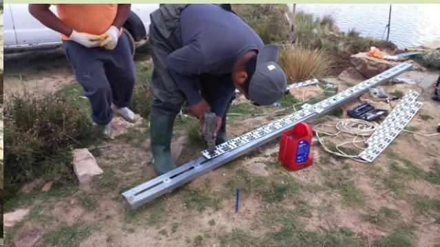
Fotos 4 y 5. Instalación del limnómetro en el puente Escoma
