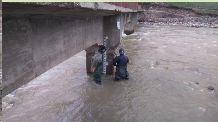
Foto 6. Capacitación a comunitarios de Wila Kala para lectura del limnómetro instalado en el puente, Ococoya
